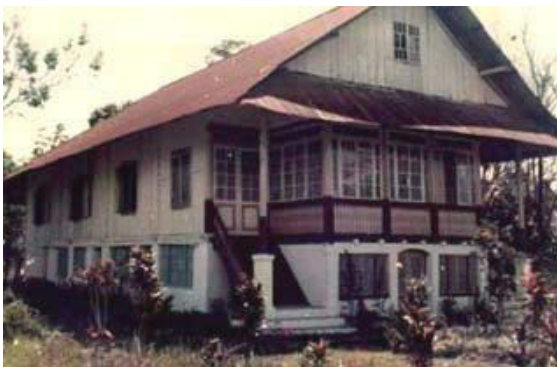
Gambar 7. Rumah dengan tiang dan kolong dari beton. (Foto Bode Talumewo Repro Ronald Kolibu 2018)
