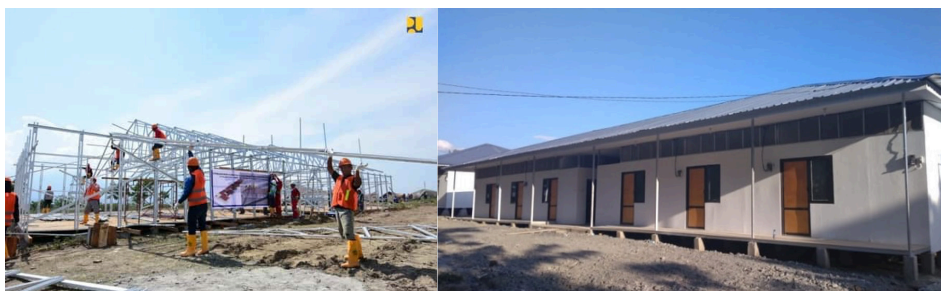
Gambar 1. Foto proses konstruksi Huntara dengan konstruksi baja ringan (sumber:website PUPR, 2019)
