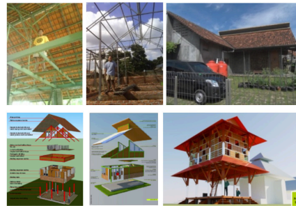
Gambar 4. Sistem konstruksi Modular Rumah Besi & Hunian di Kampung Mauk, Tangerang (Sumber: Dokumentasi Tim, 2009-2016)
