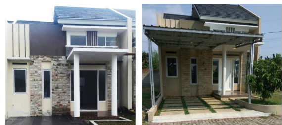
Gambar 2. Desain fasad (awal, gambar kiri) yang terhalang oleh desain kanopi carport (gambar kanan) yang ‘mengganggu’ kualitas desain.
