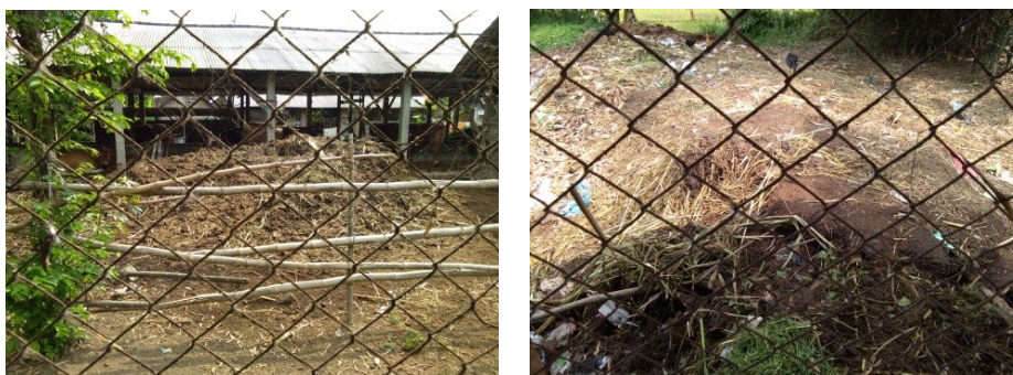
Gambar 2. Bahan baku yang menumpuk karena mesin yang rusak
