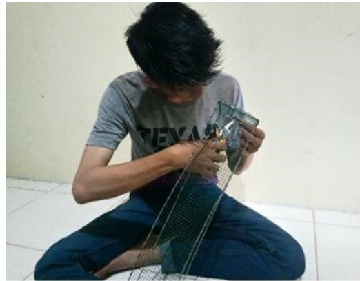
Perakitan kerangka gabion
