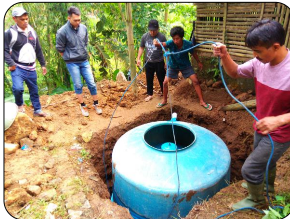
Gambar 2. Pemasangan reaktor biogas dari bahan fiberglass
