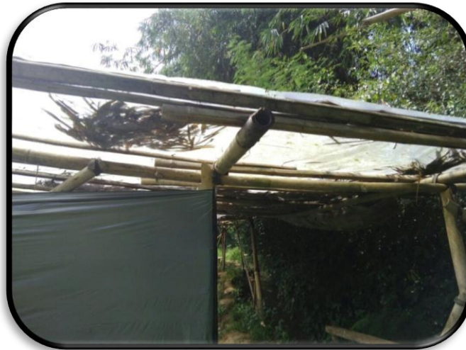
Gambar 5. Konstruksi Penutup Wadah Budidaya
