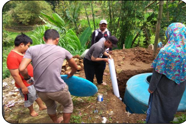
Gambar 3. Pengisian kotoran sapi ke dalam reaktor Biogas
