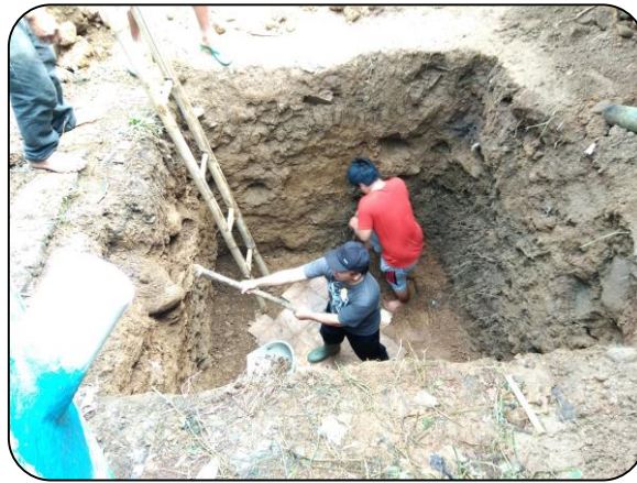
Gambar 1. Penggalian lubang untuk reaktor biogas
