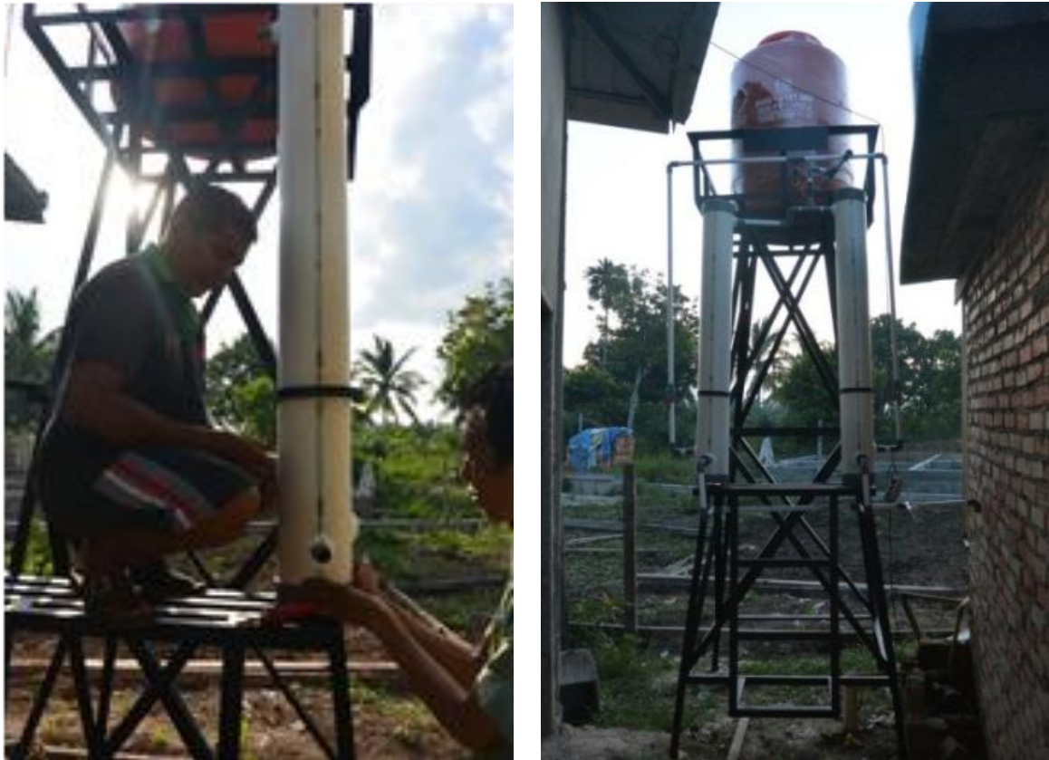
Gambar 6. Pemasangan alat di mushala
