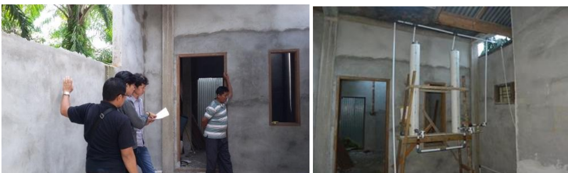
Gambar 7. Pemasangan Alat di rumah Barno
