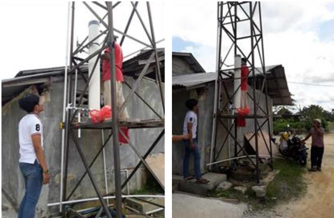
Gambar 8. Pemasangan Alat di rumah Sulis
