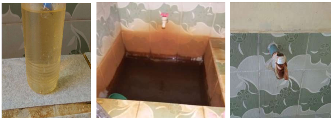
(a) (b) (c) Gambar 1. (a). Kondisi fisik air untuk wudhu dan MCK (b). Kondisi fisik air di bak kamar mandi dan dampaknya (c). Keran yang rusak karena proses perkaratan
