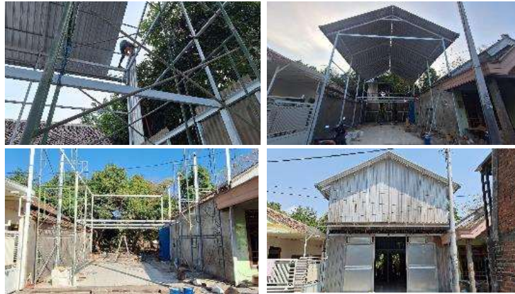
Gambar 9 Pembangunan Gudang Produksi dan Penataan Layout Proses Produksi
