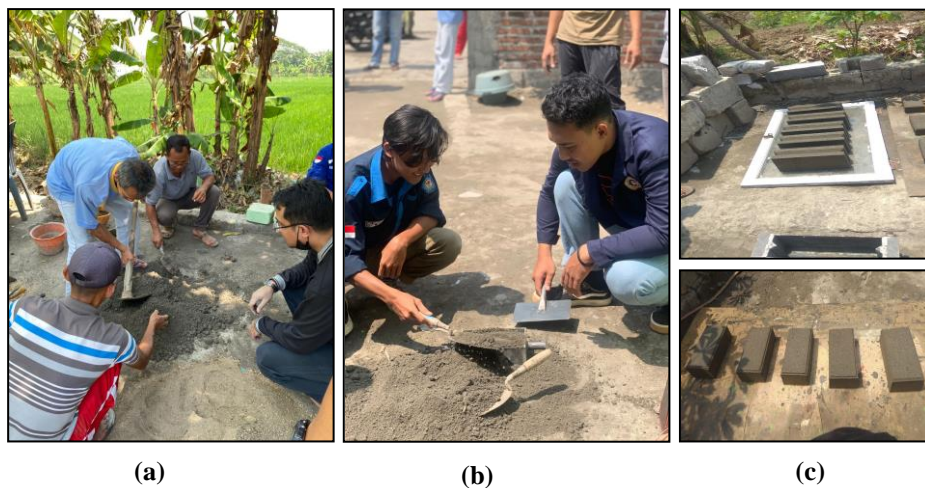
Gambar 4. Pelatihan proses pembuatan paving dan batako: (a) Pengadukan campuran. (b) Pencetakan. (c) Penjemuran hasil cetakan Paving dan Batako.
