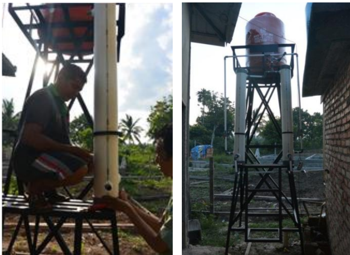
Gambar 6. Pemasangan alat di mushala
