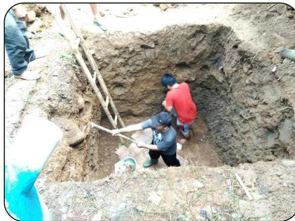
Gambar 1. Penggalian lubang untuk reaktor biogas
