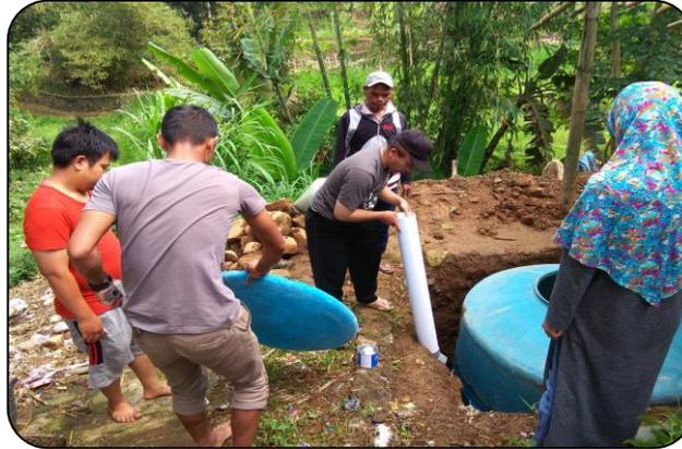
Gambar 3. Pengisian kotoran sapi ke dalam reaktor Biogas
