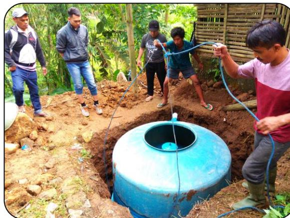
Gambar 2. Pemasangan reaktor biogas dari bahan *fiberglass*
