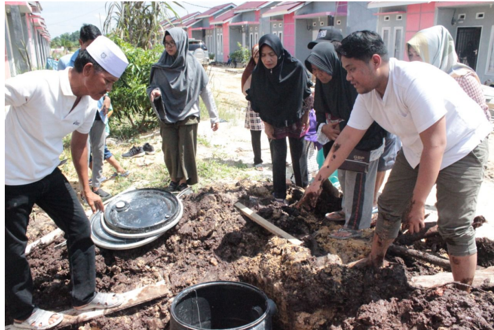
Gambar 7. Praktek pemasangan tangki septik bio-porta di salah satu rumah warga.
