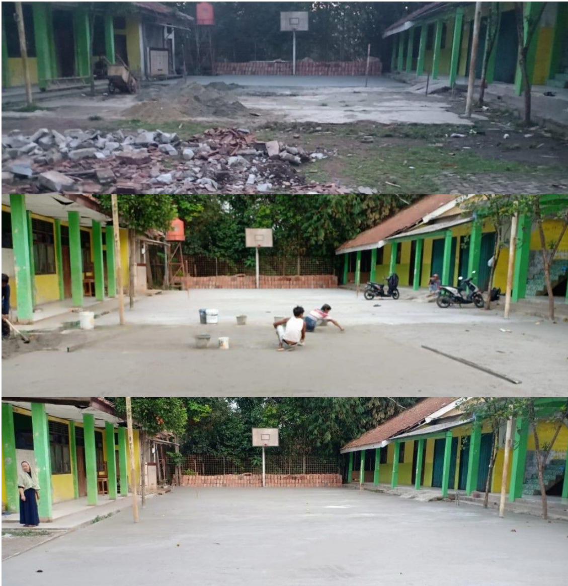
Gambar 10. Kondisi lapangan Sekolah Darussalam sebelum di perbaiki (atas), proses perbaikan lapisan beton pada lapangan Sekolah Darussalam (tengah), dan hasil akhir perbaikan lapangan Sekolah Darussalam (bawah)
