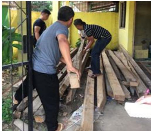
Gambar 4. Material balok kayu sisa bongkaran bangunan
