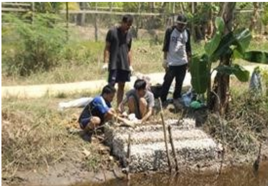
Praktek pemasangan gabion di lokasi
