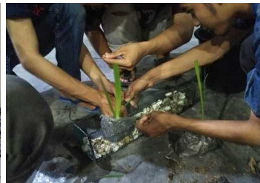
Pengisian material batu sungai, cangkang kerang dan tanaman akar wangi (vertiver)
