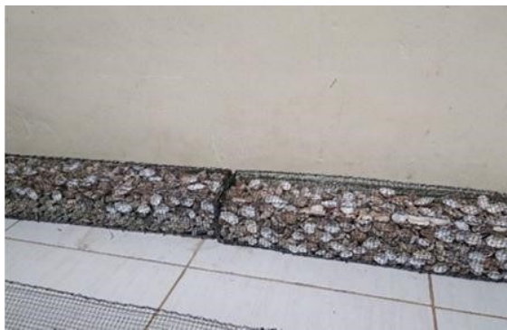
Pengisian material batu sungai, cangkang kerang dan tanaman akar wangi (vertiver)
