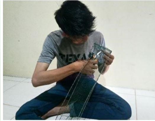
Perakitan kerangka gabion
