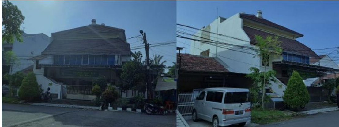
Gambar 2 Kondisi bangunan GKI Kosbar dan kondisi sekitarnya saat ini. (Sumber: Dokumentasi Pribadi, 2024)
