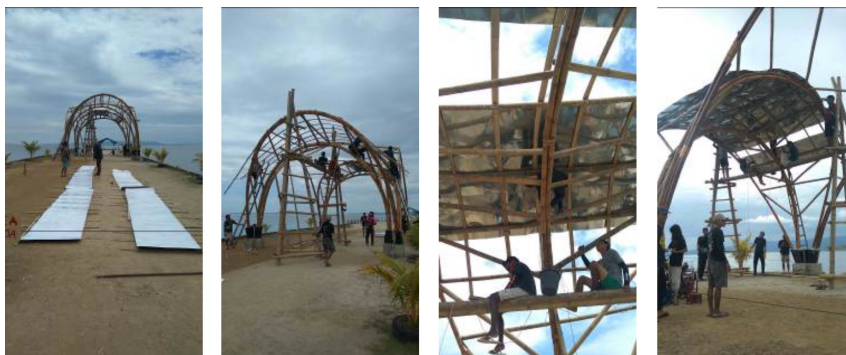
Gambar 7 Proses memasang reng dan penutup atap seng pada konstruksi kreatif bambu. (Sumber: Dokumentasi peneliti, 2019)
