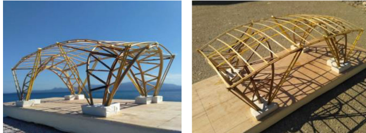
Gambar 2 Maket model hasil perubahan pada struktur atap konstruksi kreatif bambu. (Sumber: Dokumentasi peneliti, 2019)
