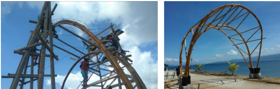
Gambar 6 Proses memasang struktur penguat ( bracing ) pada struktur portal lengkung bambu. (Sumber: Dokumentasi peneliti, 2019)
