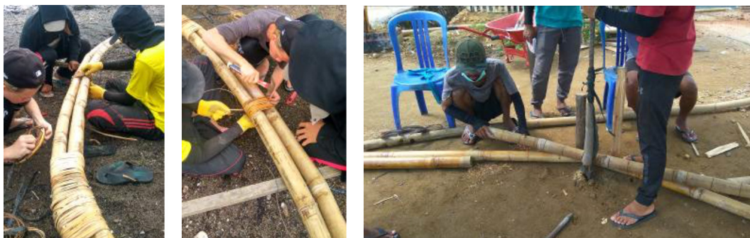
Gambar 3 Mahasiswa menyambung batang lengkung bambu dan menutup dengan tali rotan. (Sumber: Dokumentasi peneliti 2019)
