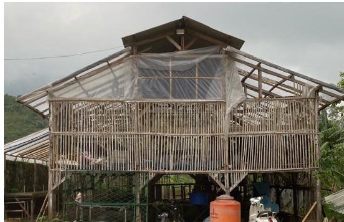
Gambar 2 Kondisi Coffee Shelter Tampak Depan Sebelum Dirancang. (Sumber: Dokumentasi Pribadi, 2024)
