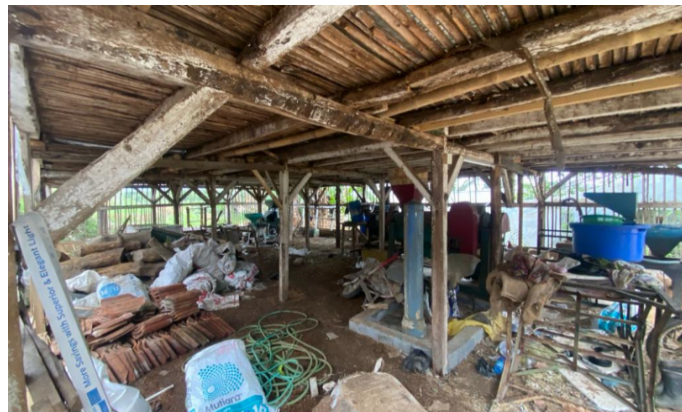
Gambar 3 Kondisi Tiang Penyangga Sebelum Didesain. (Sumber: Dokumentasi Pribadi, 2024)
