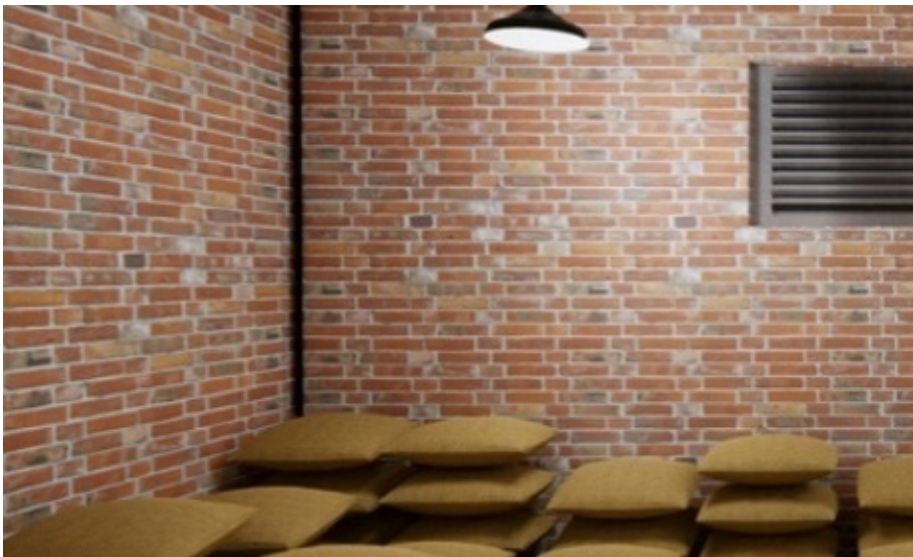
Gambar 14 Ventilasi Udara pada Gudang Penyimpanan. (Sumber: Dokumentasi Pribadi, 2024)
