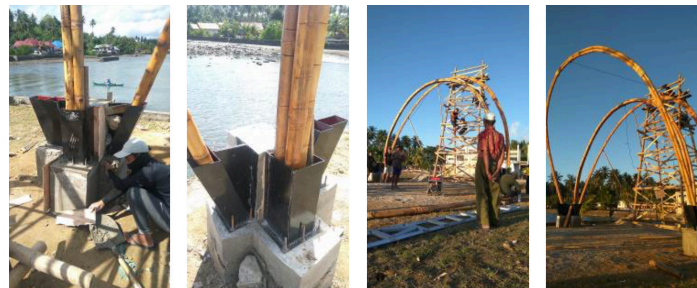
Gambar 5 Pemasangan struktur portal lengkung bambu di plat pondasi dan dengan perancah. (Sumber: Dokumentasi peneliti, 2019)
