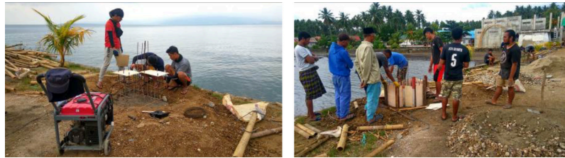
Gambar 4 Proses kerja pondasi warga Desa Lasiwa. (Sumber: Dokumentasi peneliti, 2019)
