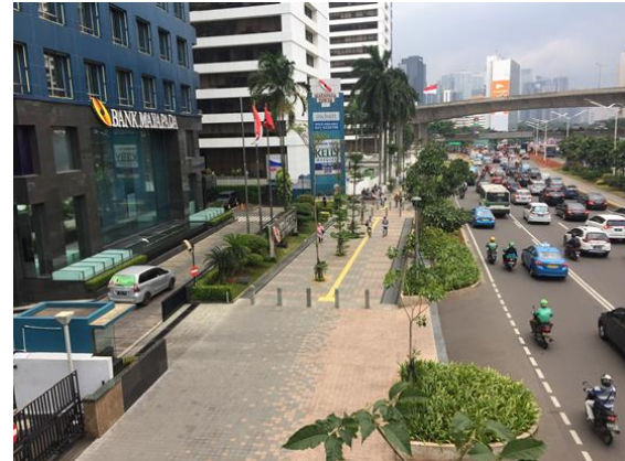
Gambar 8. Keadaan Sisi Jalan
